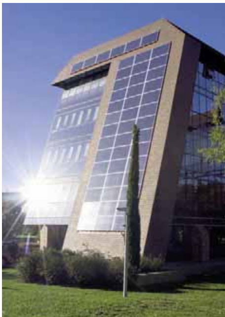
Tenesol, site de Pau – 240 kWc Installation intégrée en façades de bâtiment
