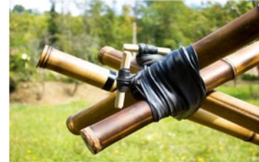
Perches de viridiglossocens traitées à la flamme dans un assemblage temporaire en chambre à air
