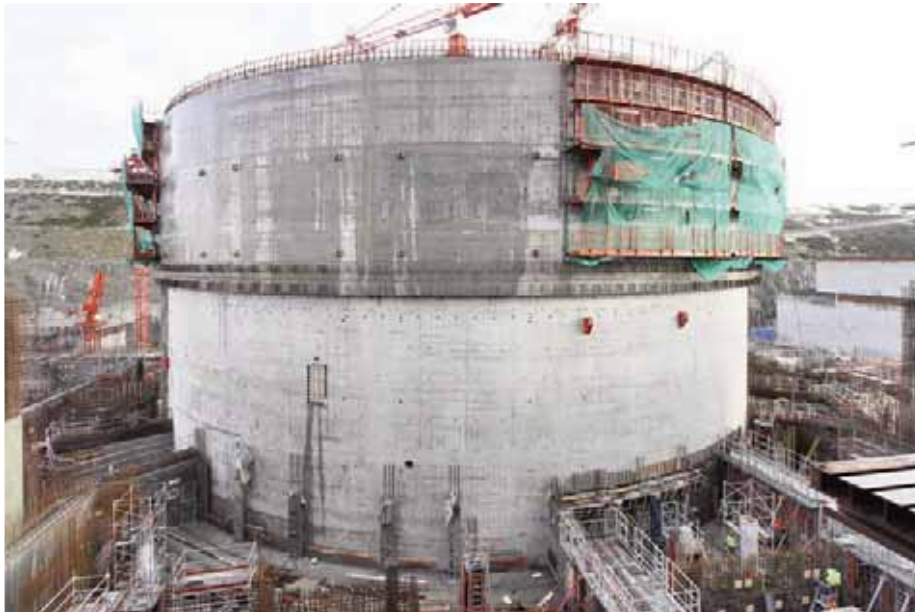
Bâtiment réacteur, chantier de l'EPR, Flamanville
