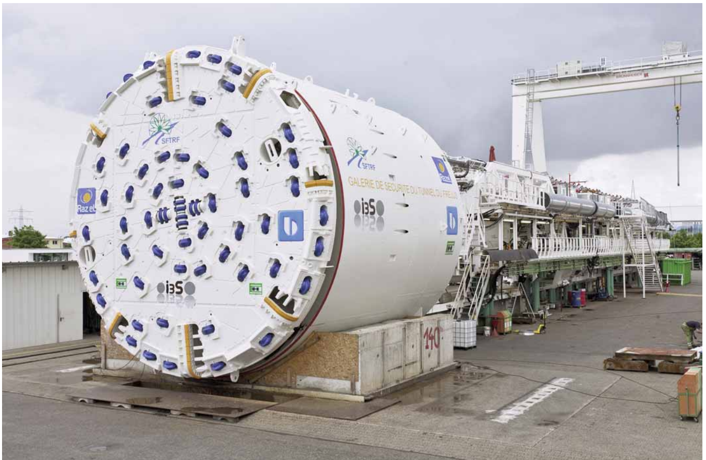
Tunnelier du chantier du tunnel de Fréjus
