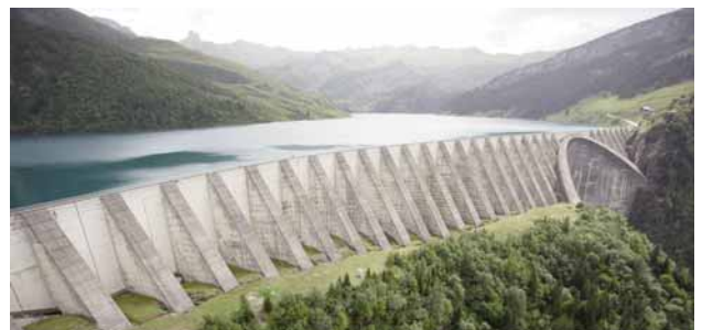
Barrage de Roselend en Savoie. Crédit Frank Oddoux
