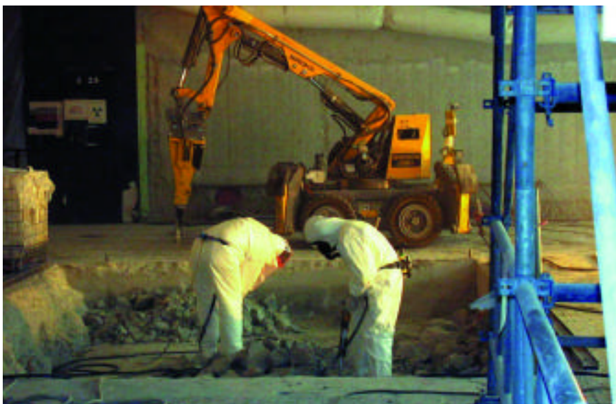
Décontamination d'un local à Brennilis
